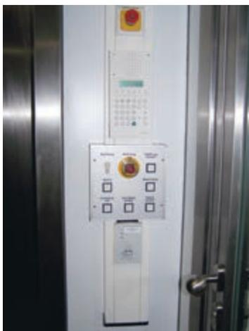
Abbildung 45: Schleusenzugang mit Wechselsprechanlage, geregelter Türfreigabe und Zugangskontrolle
