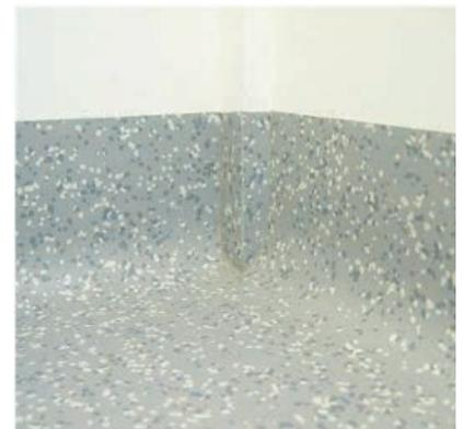
Abbildung 43: Naht- und fugenloser Übergang vom Bodenbelag zur Wand
