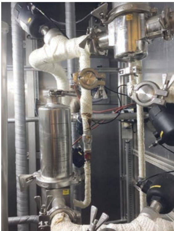
Abbildung 53: Belüftungsfiter im Technikbereich eines Autoklaven
