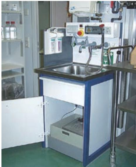
Abbildung 48: Handwaschbecken mit sterilisierbarem Auffangbehälter für Abwasser
