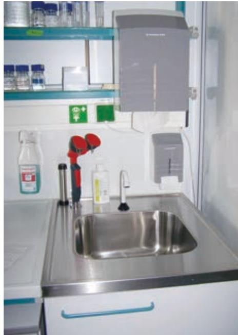
Abbildung 38: Handwaschbecken mit Sensorbedienung
