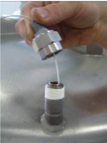
Reduziermuffe auf Anschlussstutzen aufschrauben
