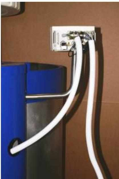
Wenn gewünscht können auch Netzkabel, Kabel für Steckernetzteil, RS 232- und RS 485 – Kabel in den mitgelieferten Kabel –Schutz – Schlauch eingeführt werden.
