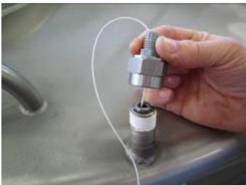
Gewinde des Anschlussstutzens mit PTFE – Dichtband eindichten.
